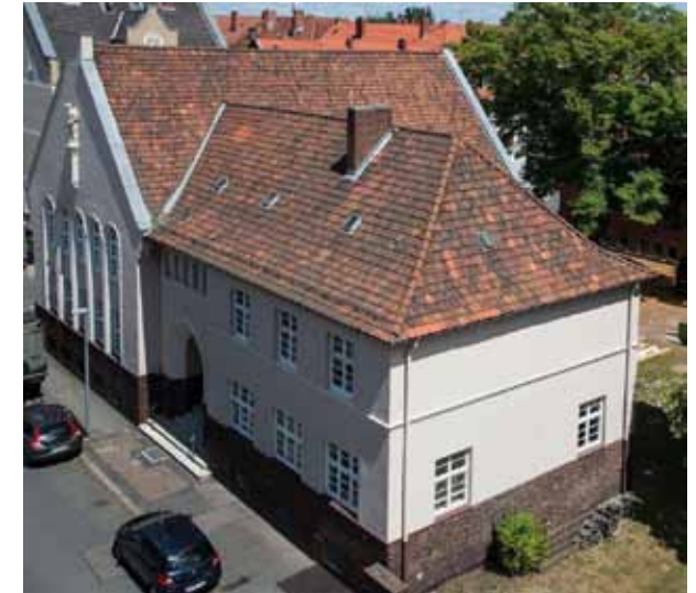
Ein neues Stadtteilzentrum für Kleefeld entsteht im ehemaligen Gemeindehaus der Petri-gemeinde.
